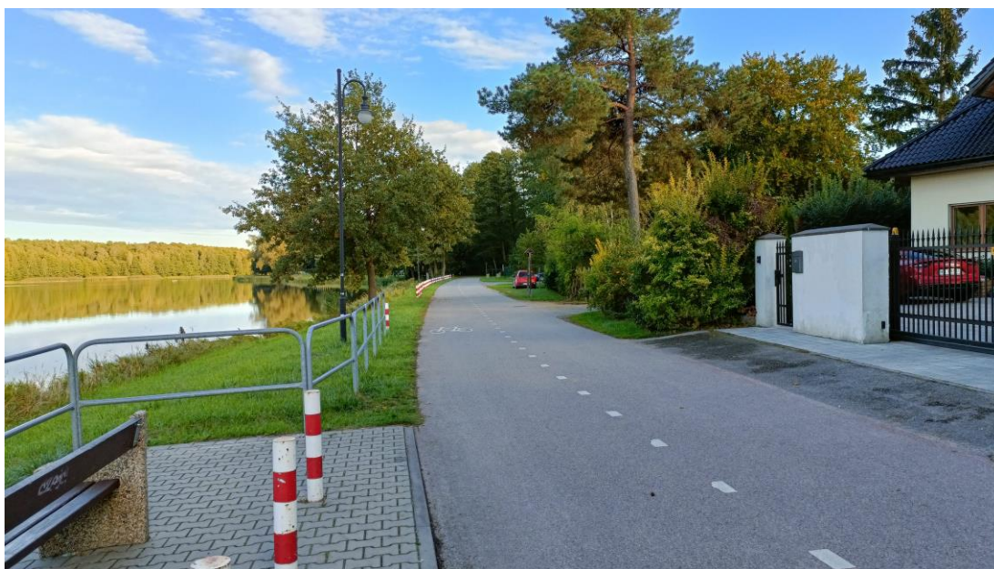
Fot. 7.5 Droga dla rowerów w Jedlni-Letnisko
