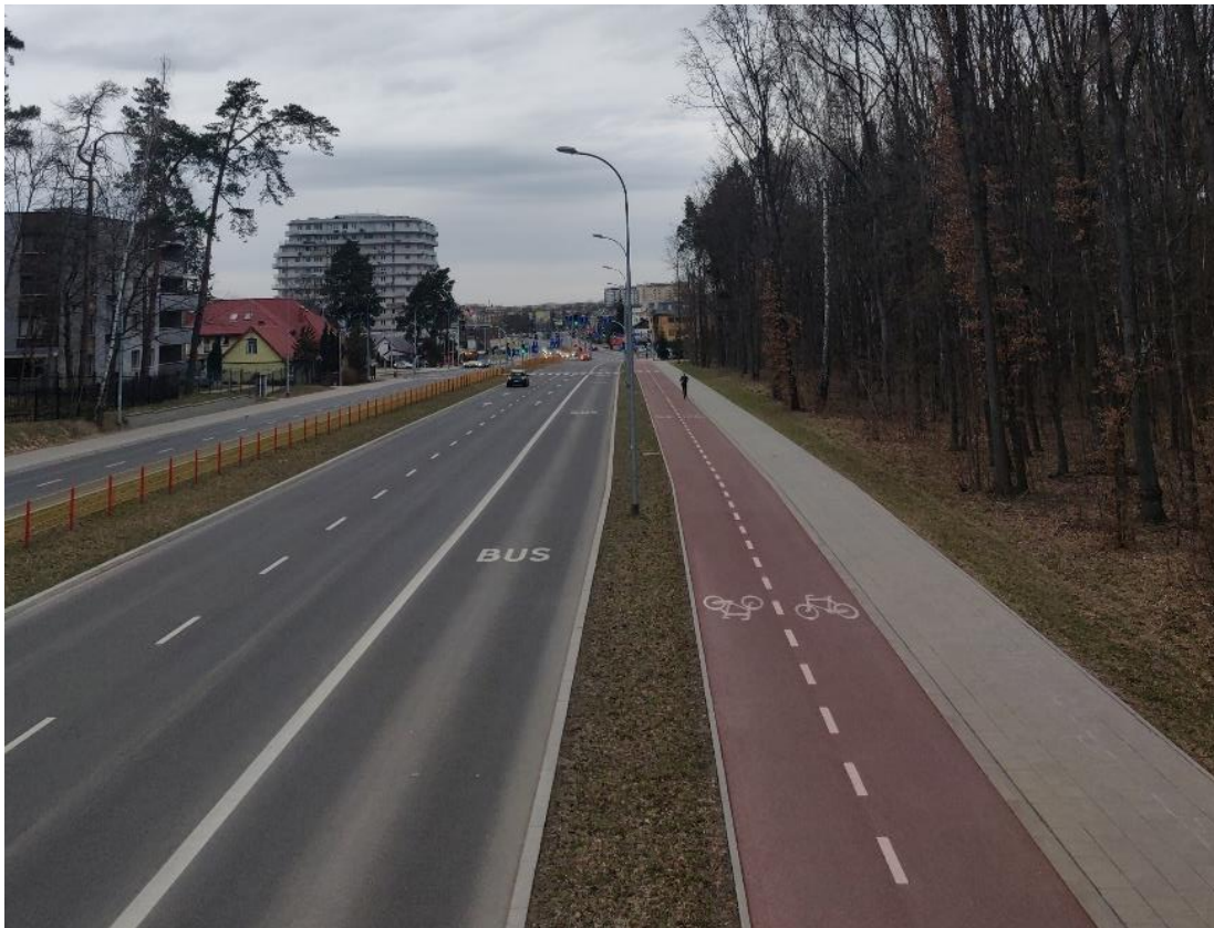
Fot. 7.2 Buspas i dedykowana infrastruktura dla pieszych i rowerów
